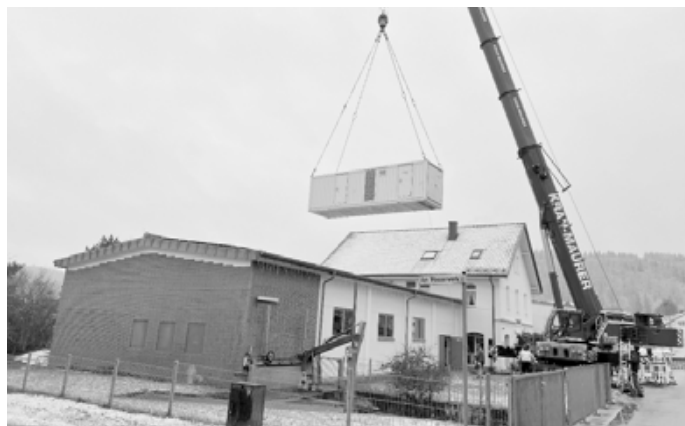
Anlieferung und Montage des Notstromaggregats im Februar 2025 mittels 5-Achsen 230-Tonnen-Kran
